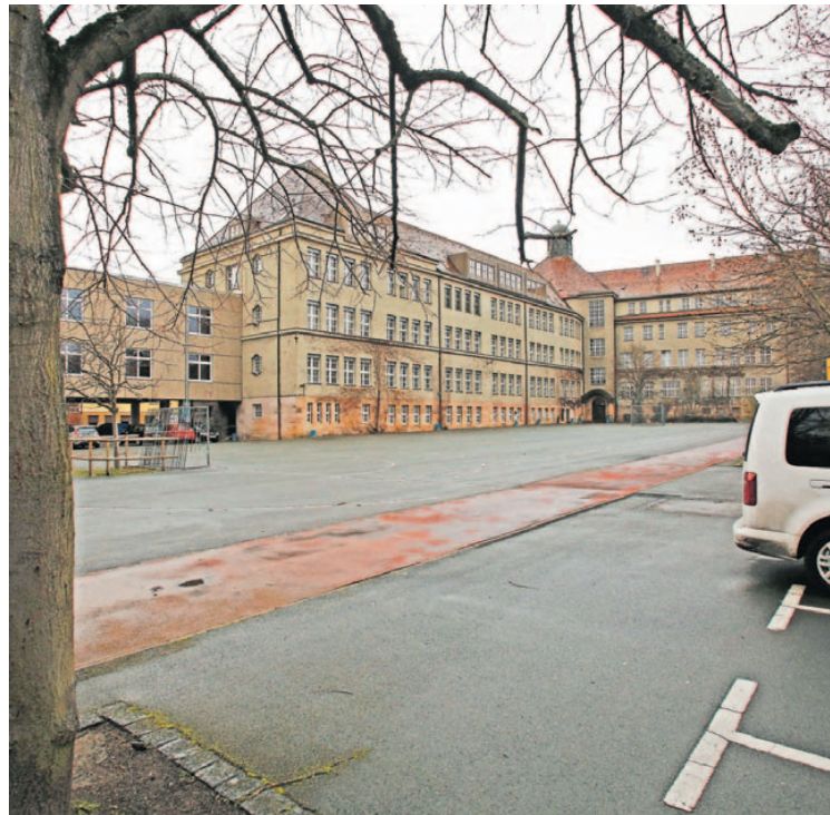
Wenig Grün, viel Asphalt: Der Pausenhof des Melanchthon-Gymnasiums wird saniert.
